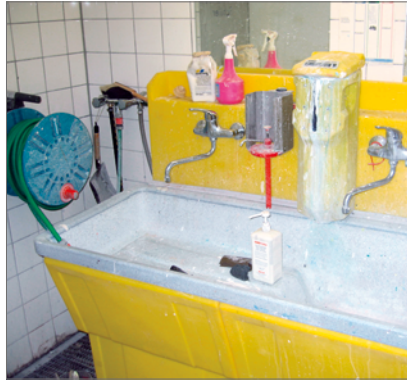
Bild 1: Waschanlage mit Abscheidung
