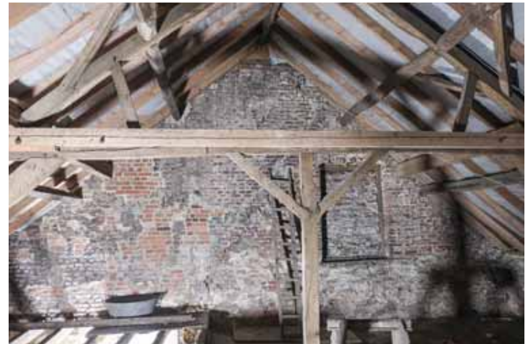
5. Haus Blumenthal, Dachraum über dem Westtrakt, Blick nach Osten auf die östliche Giebelwand; in der Mitte und rechten Bildhälfte eine ältere Giebelschräge mit zugesetztem Fenster.
