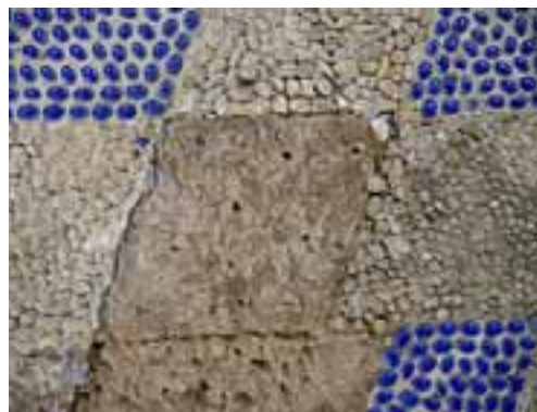
17. Brühl, Muschelkapelle. Bohrlöcher infolge des Hermetique-Verfahrens, die nach dem Ausbau zu Tage traten.
