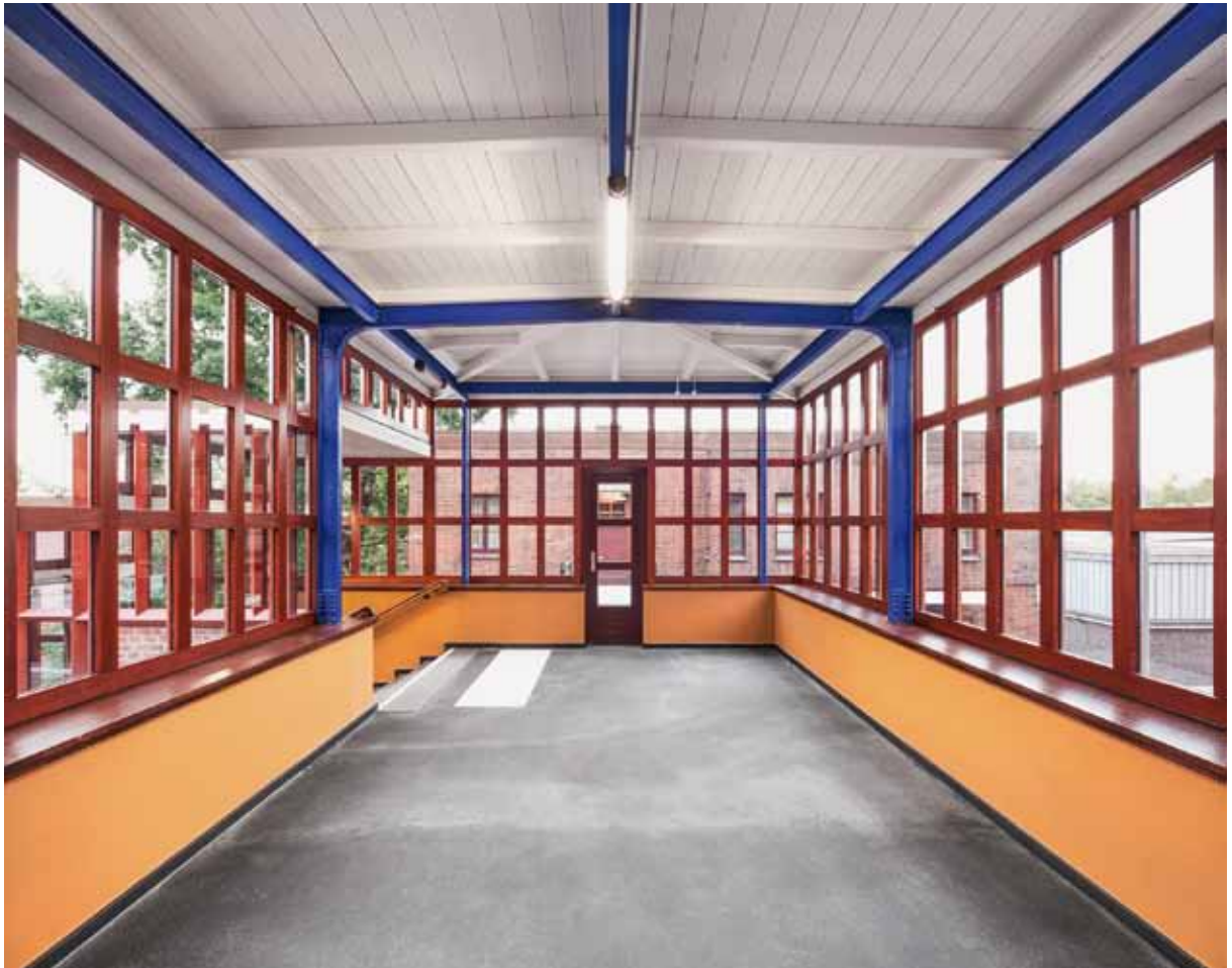
4 Hamburg, U-Bahn-Haltestelle Kellinghusenstraße, Bahnsteigbrücke, Walther Puritz, 1929–31, Rekonstruktion durch Mathias Hein Architekten, 2011–14, Foto: Sebastian Glombik
