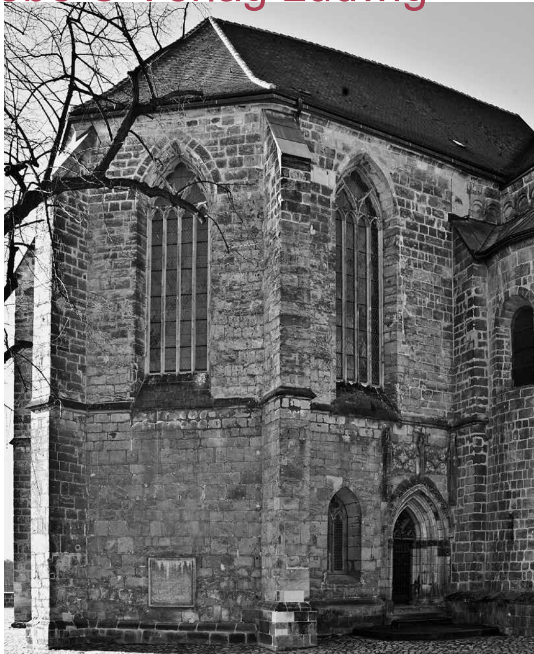
Abb. 6 St. Servatius in Quedlinburg: gotischer Chor von 1320 mit der vor allem am Rundbogenfries unterhalb der Dachtraufe gut ablesbaren Baunaht.
