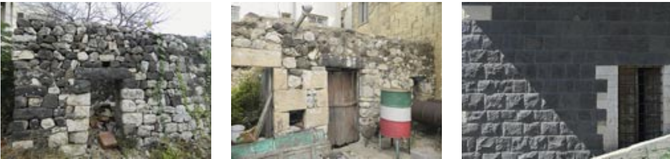
17a | mörtellostes Bruchsteinmauerwerk
