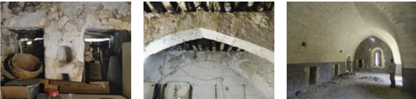
17g | Wand mit Lehmputz und Kalkschlämme
