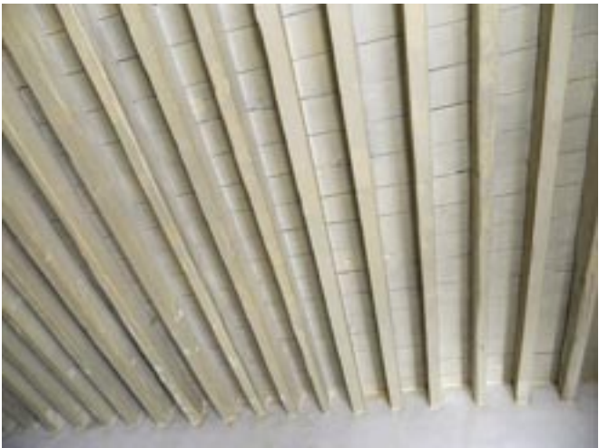
e. vorgefertigte Kanthölzer als Balkendecke im EG
