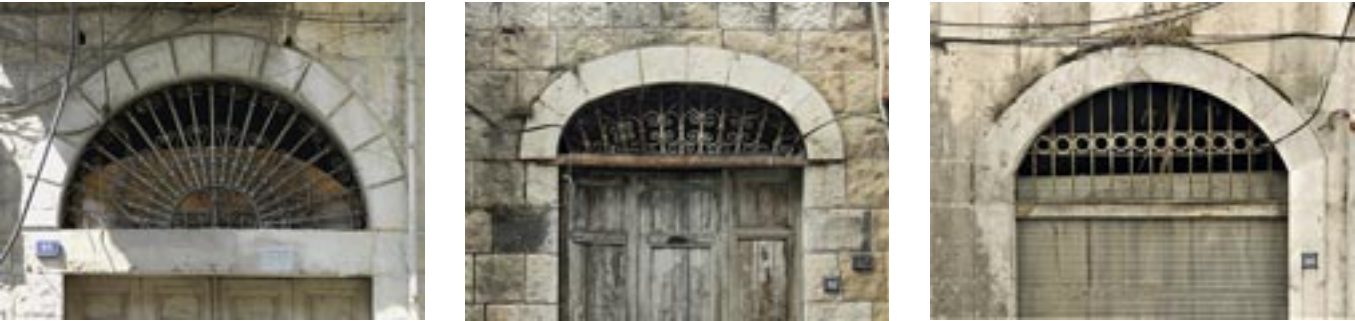
32g | monolithischer Sturz mit rundem Entlastungsbogen
