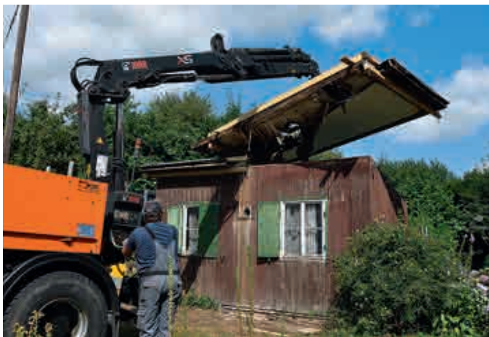
Abbau im Juli 2019: Das erste Dachsegment wird abgehoben.
