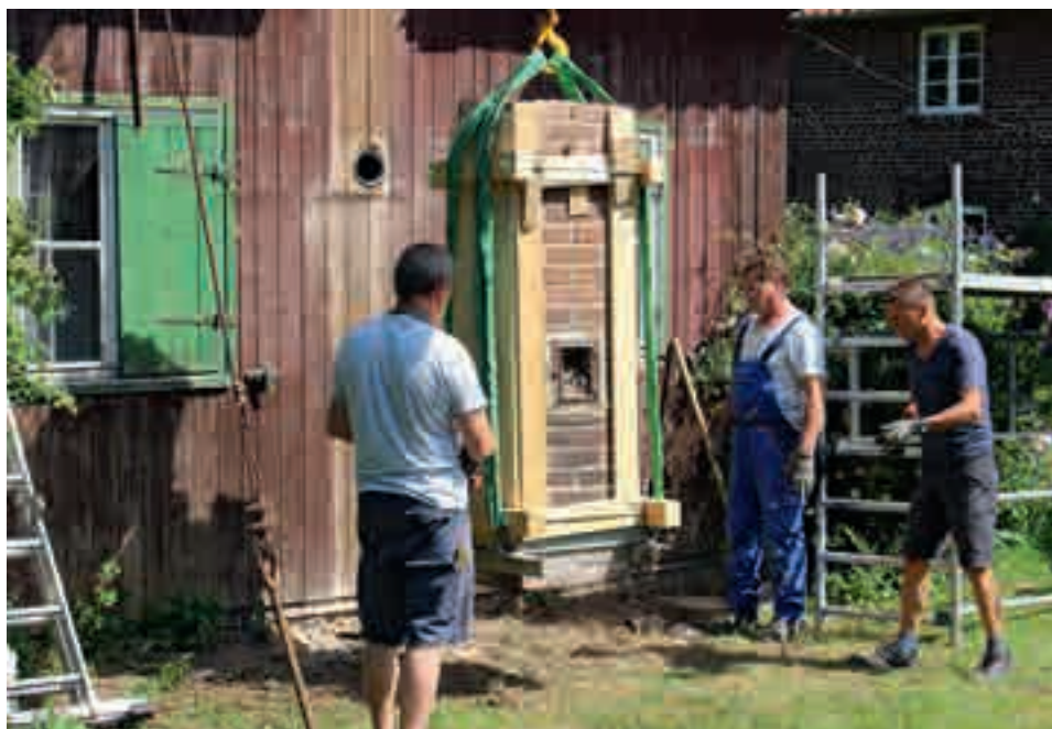
Abbau des Behelfsheims im Juni 2019: Der untere Teil des Außenschornsteins an der Südseite wird verladen.
