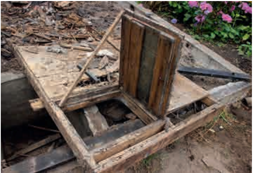
Die wiederentdeckte „Frischhaltegrube“ unter dem Fußboden des Behelfsheims. Das zugehörige hölzerne Fußbodenelement enthält die originale Zugangsklappe.
