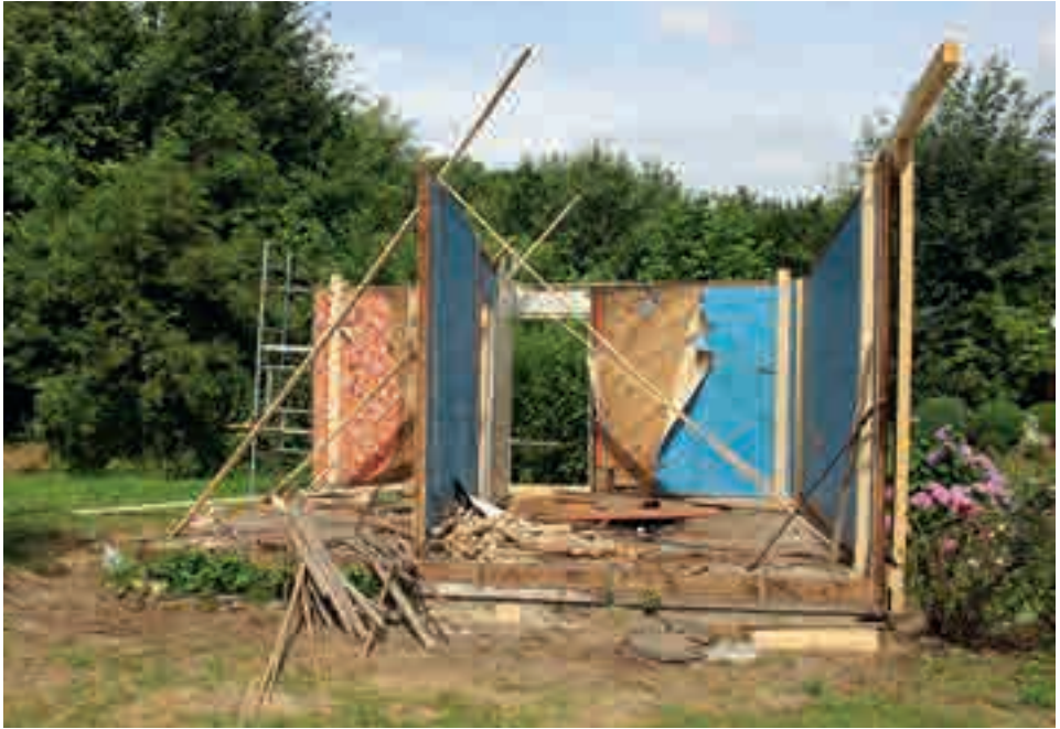
Der Blick von Süden in das zur Hälfte abgebaute Behelfsheim lässt die Bauweise aus vorgefertigten Holztafeln gut erkennen, im Hintergrund die Eingangstür.
