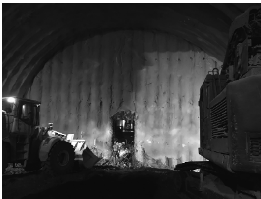
Bild 15. Vortrieb der Röhre 825, Durchschlag zu BA 25
