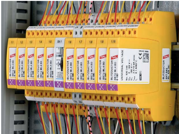
Bild 4.14 Blitzductor – Kombiableiter mit aktiVsense-Technologie und integrierter LifeCheck-Überwachung
