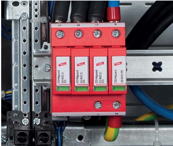
Bild 4.10 DEHNGuardCI – modularer Überspannungsableiter mit integrierter Vorsicherung
