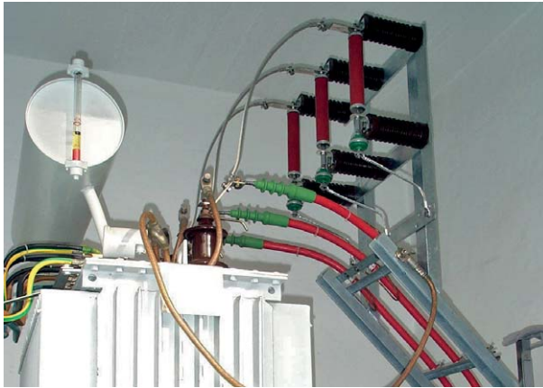
Bild 4.12 DEHNmid – Überspannungsableiter für Mittelspannungssysteme
