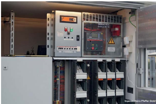
Bild 4.9 Intelligente Ortsnetzstation mit integriertem Blitzstrom- und Überspannungsableiter DEHNvenCI zum Schutz der Niederspannungshauptverteilung
