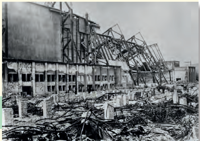
Ein zerstörtes Messegebäude in Leipzig.
