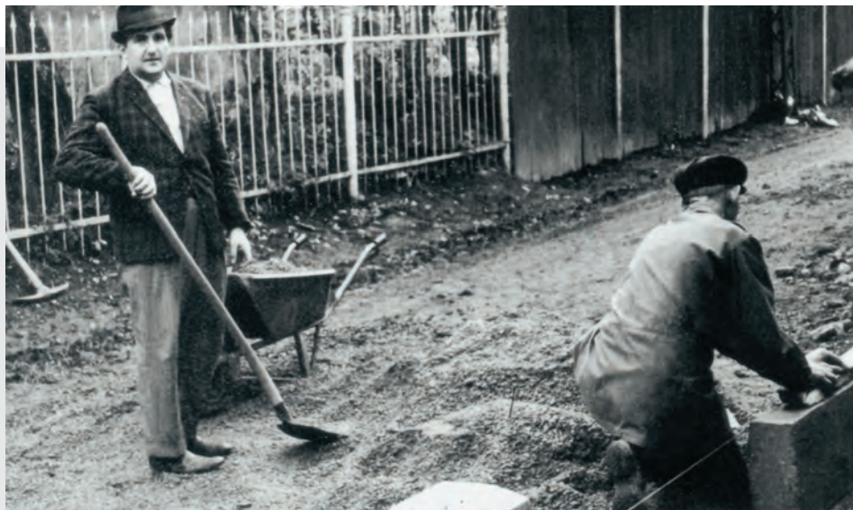
Aufbaustunden beim Gehwegbau.
