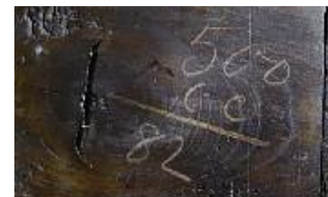
15 Rückseite des Pfeilerschranks mit Zahlenaufschrift | Rear side of the column cabinet with inscribed numbers
