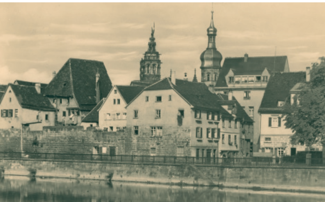
Die Obere Neckarstraße um 1940. Manche Hausfassaden saßen direkt auf der Stadtmauer auf.
