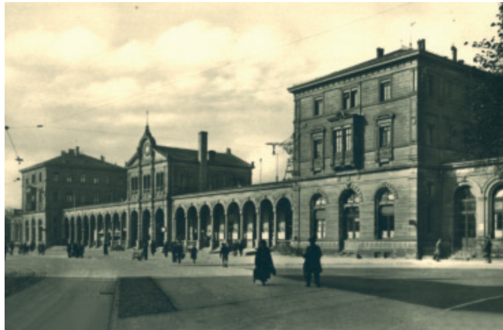
Hauptbahnhof von Osten, um 1905.
