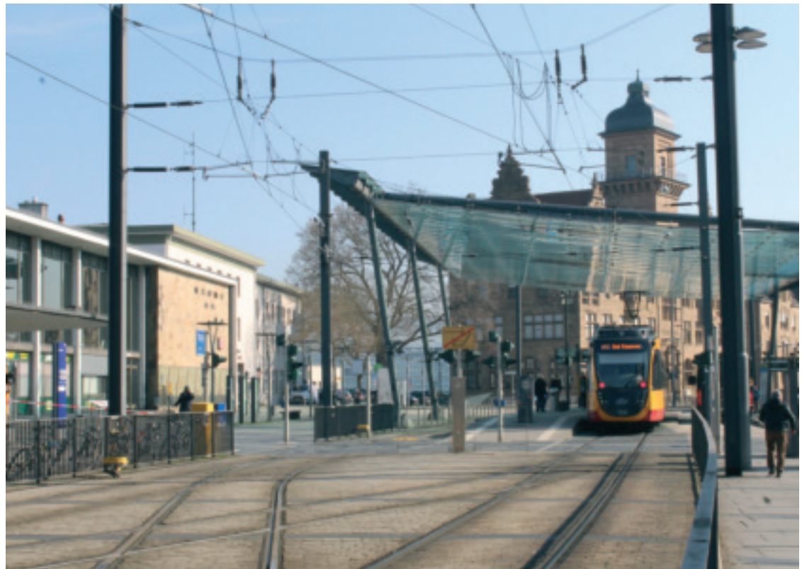
Seit Eröffnung der Stadtbahn, die wie einst die historische „Spatzenschaukel“ über den Vor- platz fährt, schützt ein weit aus- ladendes flügelartig geschwunge- nes Glasdach die Haltestelle „Willy-Brandt-Platz“.
