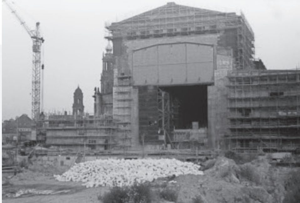
Die Baustelle 1980. Um die Seitenbühnen zu vergrößern, wurden die Außenmauern jeweils um 8 m nach außen versetzt.
