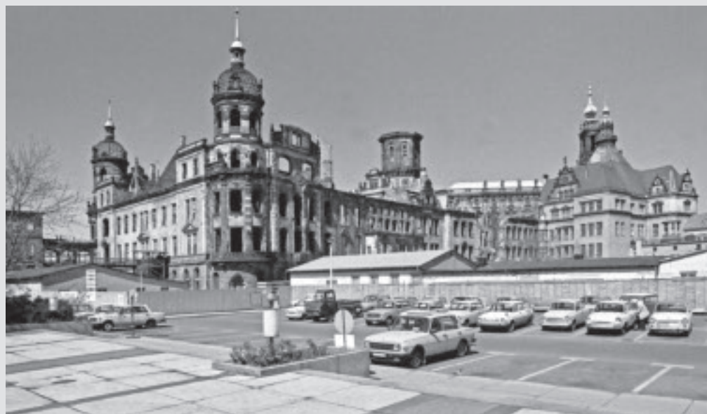
Zustand während der Sicherungs- und Abrissarbeiten im April 1987.
