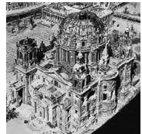
Kriegsbeschädigter Dom mit zerstörter Eisenkonstruktion der Schuttkuppel über der erhaltenen Innen- kuppel, um 1947
