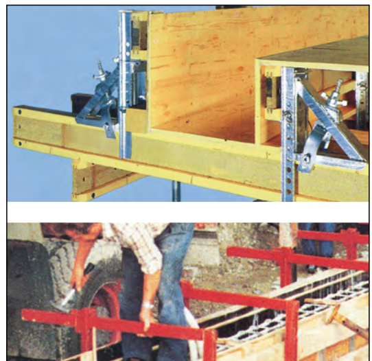
Bild 3: Schalung von Balken
