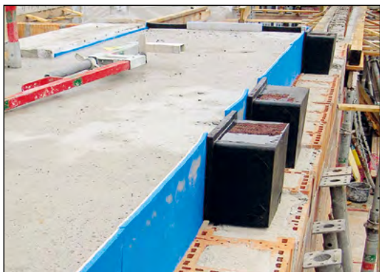
Bild 1: Zwischenpodest einer Treppe mit schallgeschützten Auflagerköpfen
