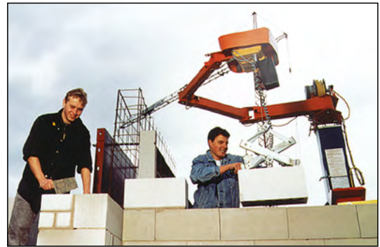
Bild 1: Versetzen einer Steinreihe mit der Greifzange eines Versetzgerätes
