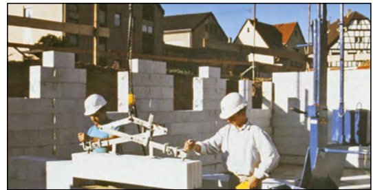
Bild 2: Versetzen von Steinreihen
