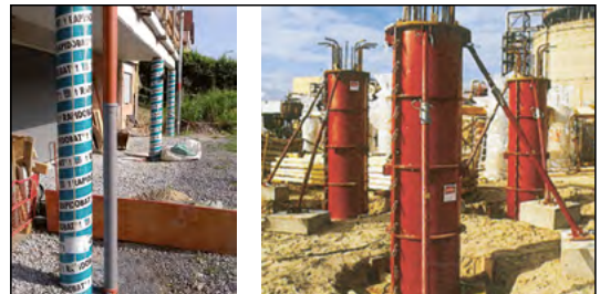
Bild 2: Schalung von Rundstützen
