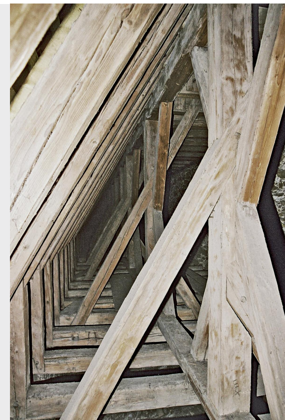
3 Langhausdachwerk, Stuhlwand auf der Ebene über dem südlichen Seitenschiff mit sparrenparalleler Strebe, links die Sparrenknechte.
