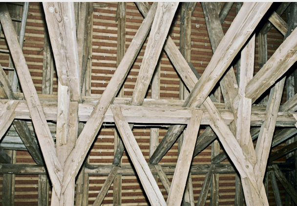
2 Langhausdachwerk, Detailaufnahme der Mittlwand mit Längsverstrebung, Blick auf die 1. Kehlbalkenebene.
