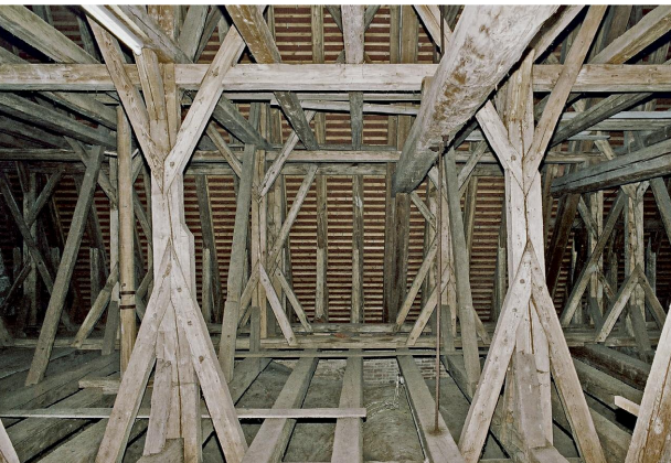
1 Langhausdachwerk, Blick Richtung Norden, im Vordergrund die längsverstrebt Mittlwand.
