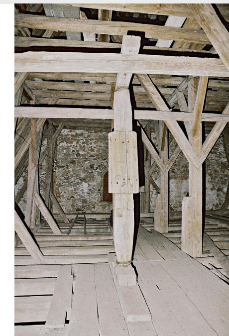
4 Langhausdachwerk, Aufzugsspindel in der Hauptebene, Blick Richtung Osten.
