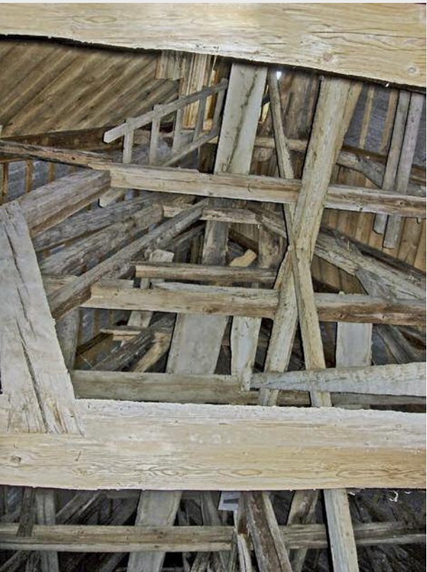
6 Chordachwerk, Blick von der 1. Kehlbalkenebene Richtung First.
