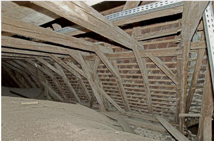
2 Langhausdachwerk, Detailaufnahme der liegenden Stuhlkonstruktion mit Blick Richtung Nordosten.
