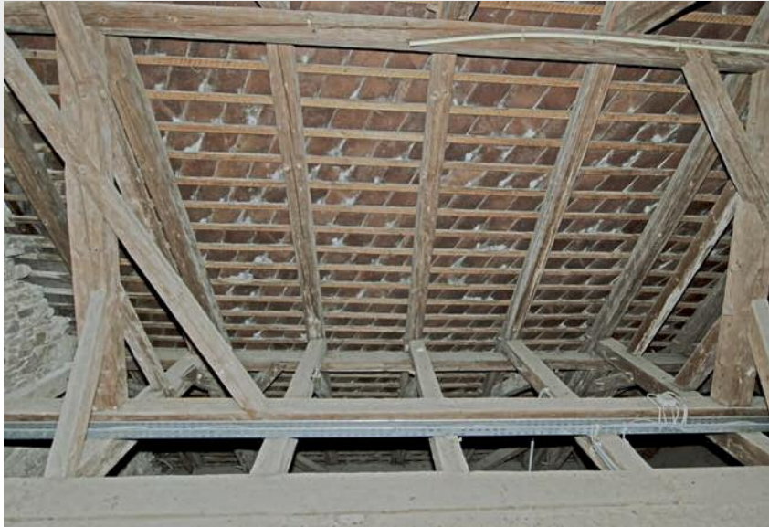
3 Langhausdachwerk, Detailaufnahme Stuhlwand über der 1. Kehlbalkenlage.
