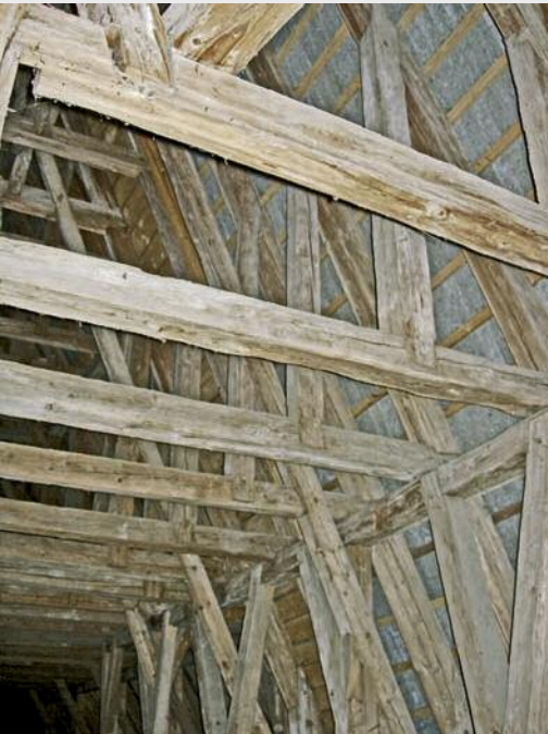
5 Chordachwerk, Blick auf die 1. Kehlbalkenebene mit Sparrenstreben.
