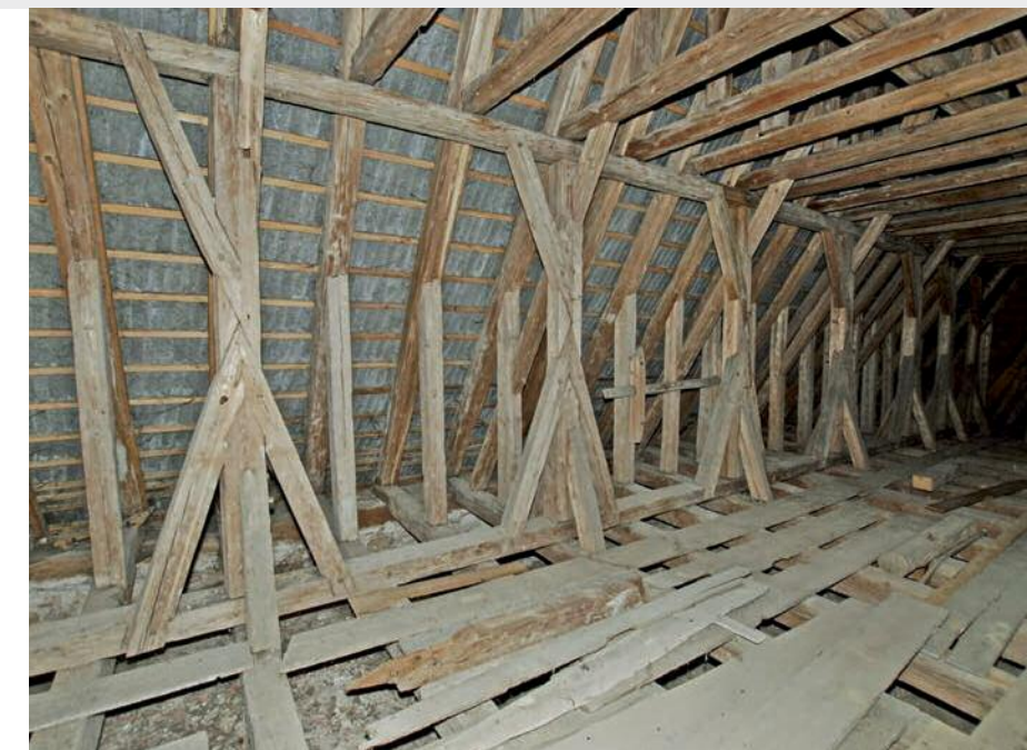
1 Langhausdachwerk, Fußpunkt der Sparren über der Mauerbank mit doppelter Mauerschwelle, rechts eine Stuhlsäule mit sparrenparalleler Strebe.
