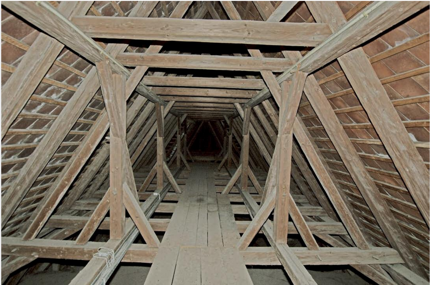
1 Langhausdachwerk über der 1. Kehlbalkenlage mit Blick Richtung Osten.
