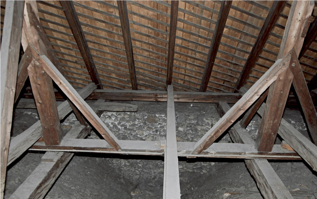
4 Langhausdachwerk, Detailaufnahme Fußbereich südliche Stuhlwand.
