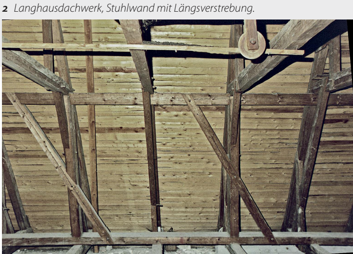
2 Langhausdachwerk, Stuhlwand mit Längsverstrebung.
