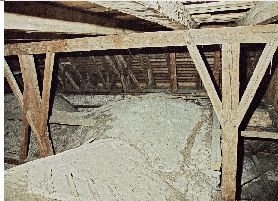
4 Langhausdachwerk, Unterstellung der ersten Kehlbalkenebene mit verstreuten Säulen.
