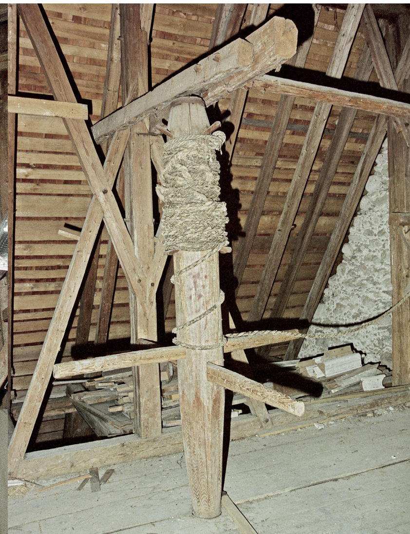
2 Langhausdachwerk, Detailaufnahme Aufzugspindel.
