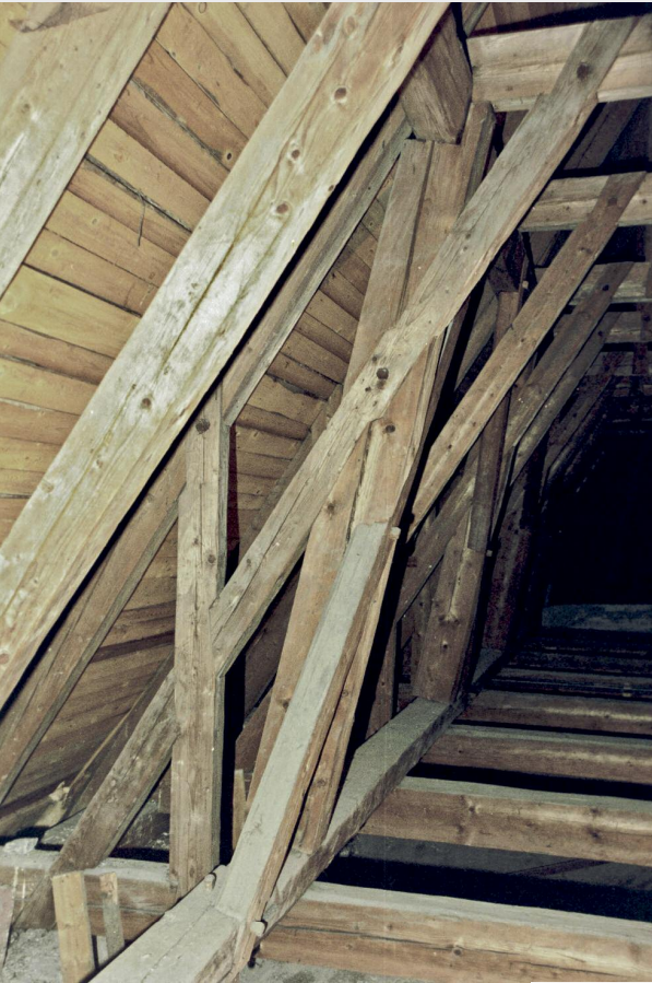
3 Langhausdachwerk, Stuhlwand mit Querverstrebung.
