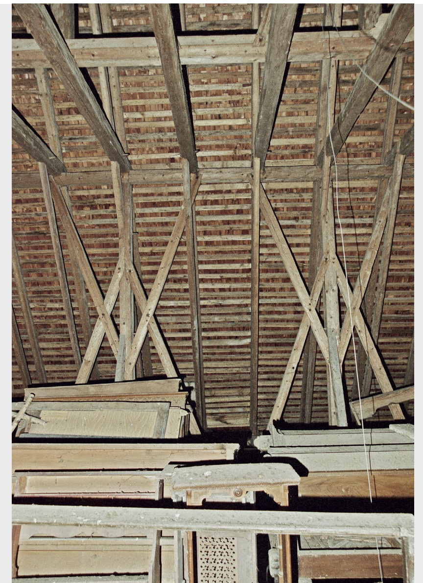
3 Langhausdachwerk, Längsverstrebung der Stuhlwand.
