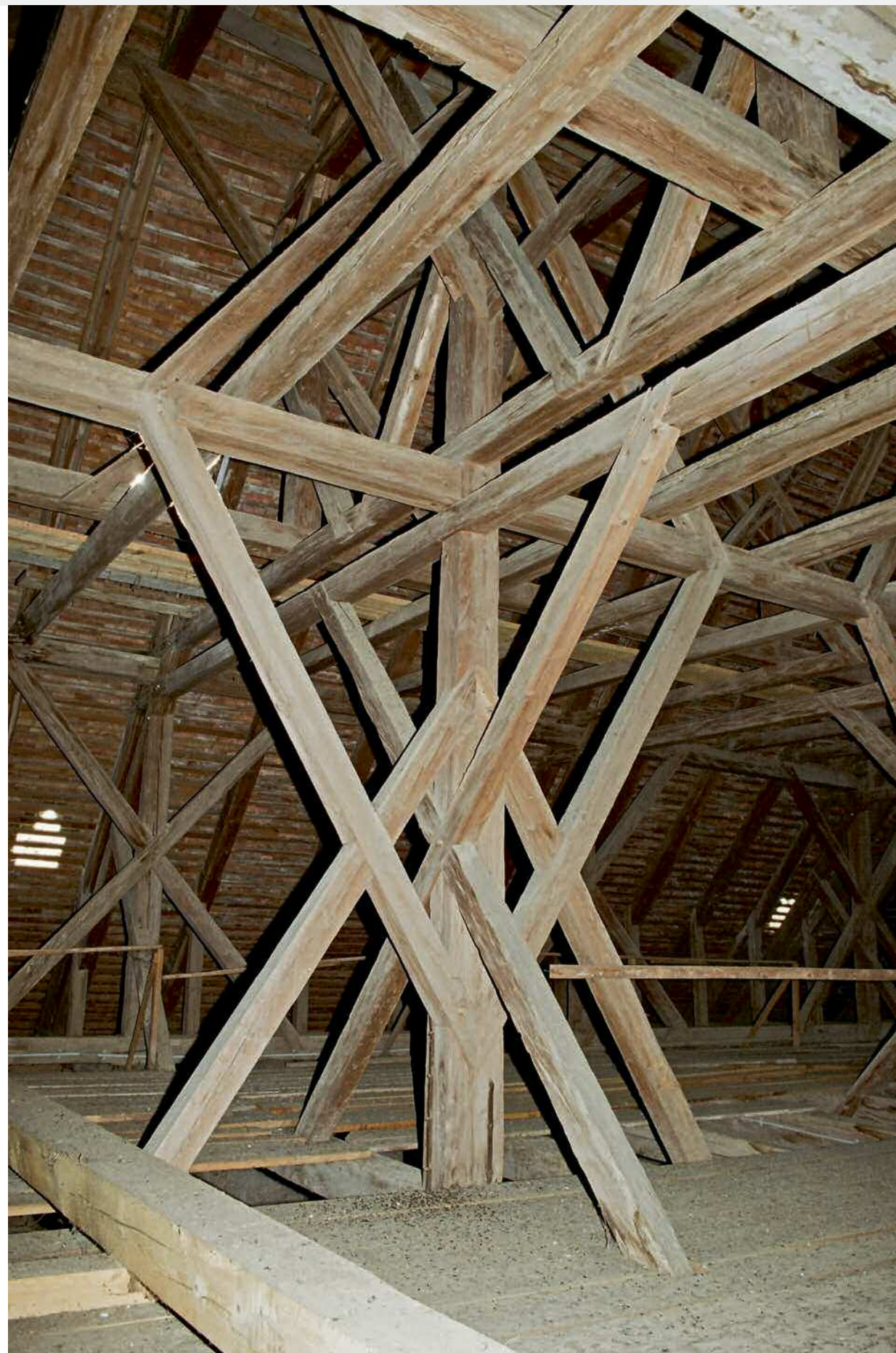
191 Wallfahrtskirche Pöllauberg (ST), doppelte K-Streben im Längsverband
