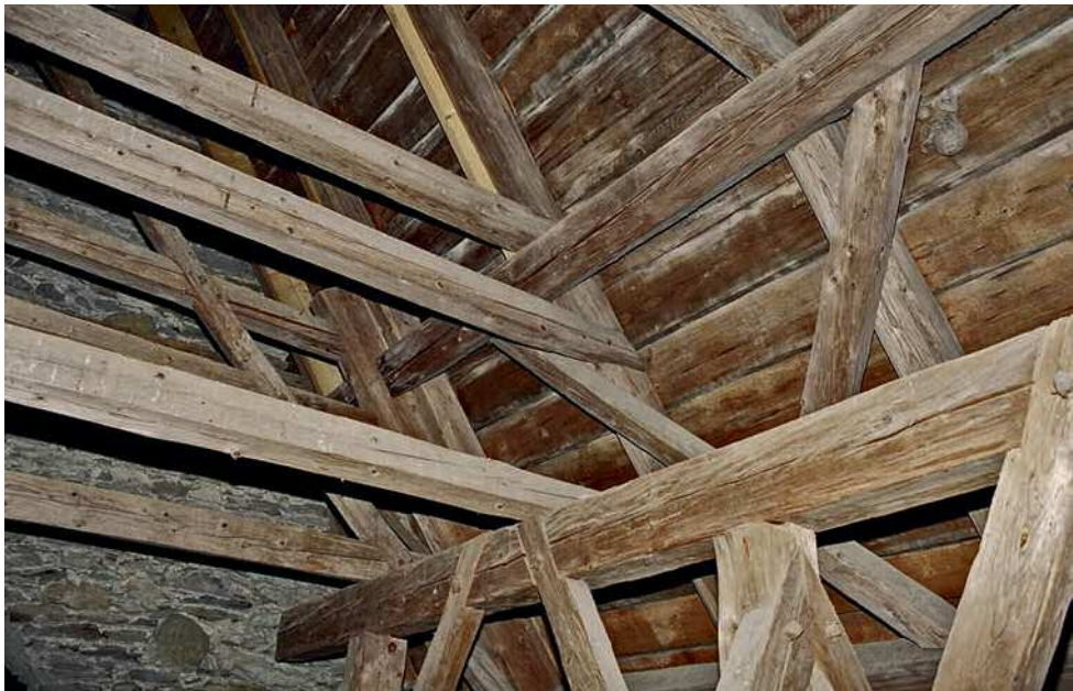
195 Pfarrkirche St. Gandolf (K), Seitenpfetten zwischen doppelten Kehlbalcken, Stuhlwand sekundär eingestellt
