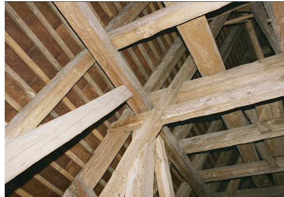
192 Pfarrkirche St. Willibald (OÖ), Seitenpfette zwischen doppelten Kehlbalken und sparrenparalleler Strebe mit überplatteter Stuhlsäule
