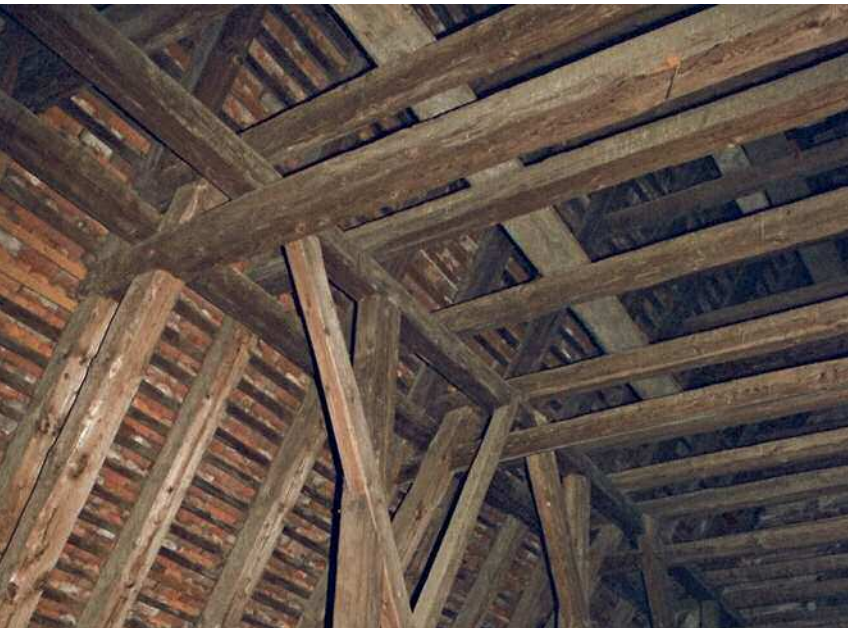
194 Filialkirche Maria Lebing in Hartberg (ST), doppelte Kehlbalcken umschließen Rähm und Seitenpfette
