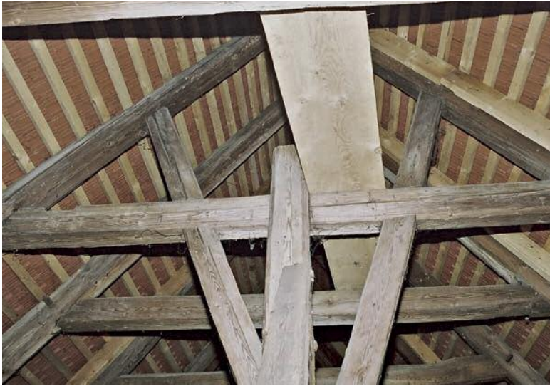
3 Langhausdachwerk, Aufhängung der Säule am Hahnenbalken und an den Sparren.
