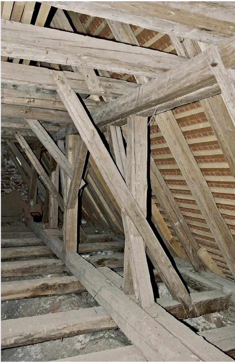
1 Langhausdachwerk, Stuhlwand über dem nördlichen Seitenschiff.
