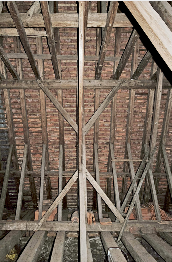
2 Langhausdachwerk, Detailaufnahme der nördlichen Stuhlwand.
