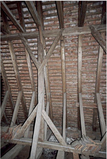
6 Chordachwerk, Detailaufnahme der südlichen Stuhlwand.
