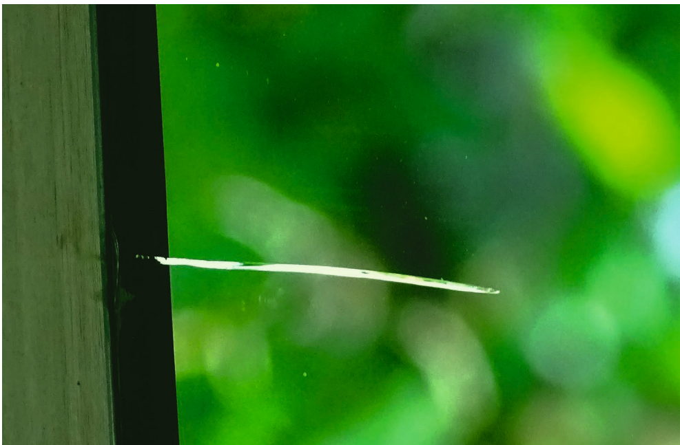
Schwacher thermischer Sprung, entstanden durch Schlagschatten in der Abkühlphase (zeitverzögert).
