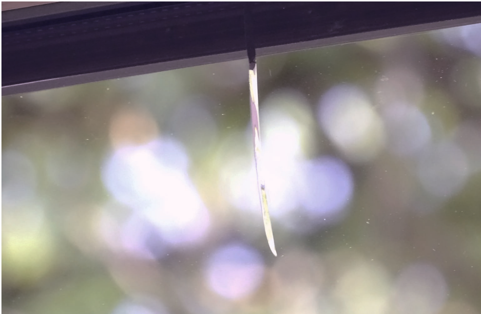
Thermischer Minimalsprung, an oberer Glaskante bei sehr tiefem Falzeinstand entstanden.
