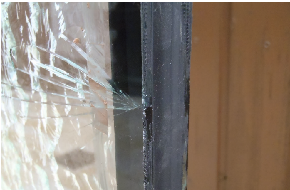
Bruch aus Bild oben, jedoch Kantenanblick, auch hier der rechtwinklig zur Glasoberfläche durch das Glas verlaufende Bruch erkennbar, typischer thermischer Bruch, jedoch mit sehr hoher Energieeinwirkung.
