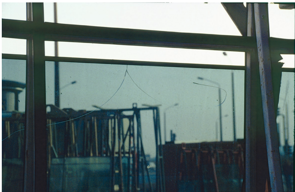
Thermischer Bruch an nicht vorgespanntem, absorbierendem Sonnenschutzglas.
