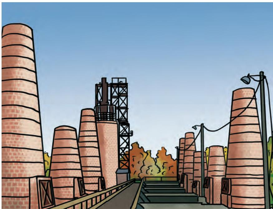
Kippwagen hierhergebracht und in Schichten abwechselnd in die Öffnungen hier oben geschüttet. Diese Anlage war ein riesiger technischer Fortschritt, mit der in der gleichen Zeit tausend Mal so viel Kalk gebrannt werden konnte wie vorher. Das hier war der erste Schachtofen weltweit, darum werden Schachtofen von Fachleuten auch ‚Rüdersdorfer Öfen‘ genannt.“
