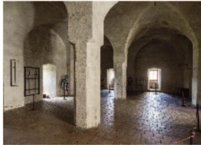
Abb. 20: Schwihau (Svihov), Wasserburg, mit romanisierenden Gratgewölben gewölbter Saal im ersten Obergeschoss des Südflügels der Kernburg, errichtet zwischen 1480–1489 (inschr.)
