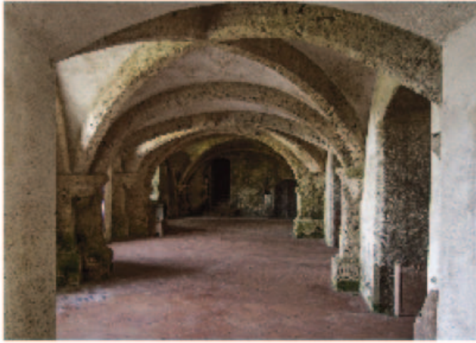
Abb. 17: Burghausen, herzogliche Residenz, mit romanisierenden Bandrippengewölben gewölbtes Erdgeschoss des Kernbaus, um 1480/83, vielleicht unter der Leitung Ulrich Pesnitzers
