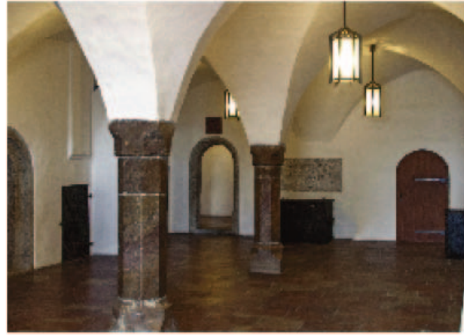
Abb. 18: Hohensalzburg, Hoher Stock, mit romanisierenden Gratgewölben gewölbte Mittelhalle, um 1485
