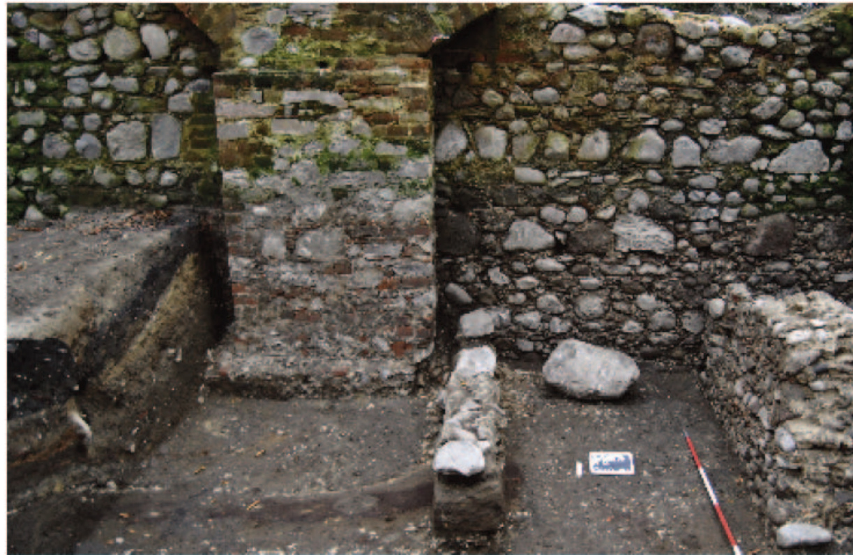
Abb. 1: Wittenberg, Schlosshof, Ringmauer der askanischen Burg mit sekundär angesetzter Verstärkung aus Ziegelsteinen
