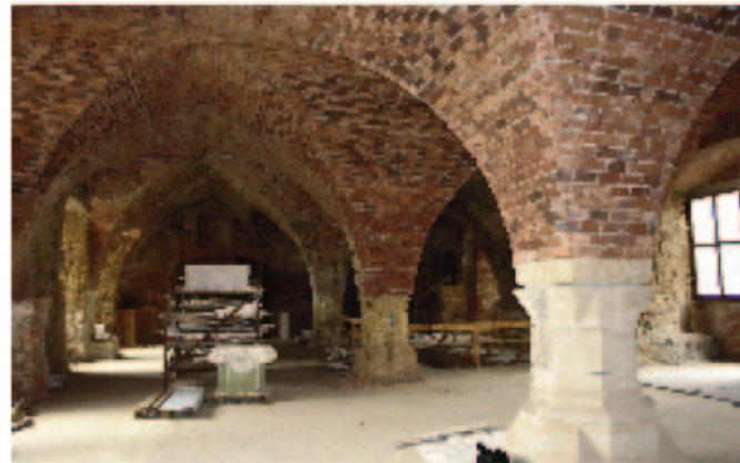
Abb. 22: Dresden, Residenzschloss, mit romanisierenden Gratgewölben gewölbte Halle im Erdgeschoss des Ostflügels (Hofstube?), vermutl. Arnold von Westfalen um 1471
