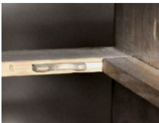
Abb. 4 versteckte Verriegelung für die Jalousie vom Mittelfach des Eingerichtes
