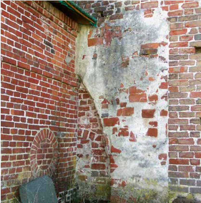
Bauspuren des Vorgängerbaus in der Nordwand (Mitte 13. Jh.): Nische, Gewölberippe und Verzahnung (vermauert/verputzt)
