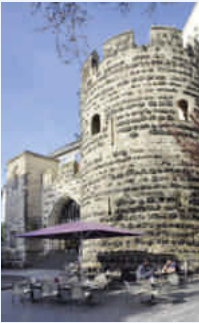
Ein Stadttor mitten im Zentrum? Da wurde nachgeholfen.
