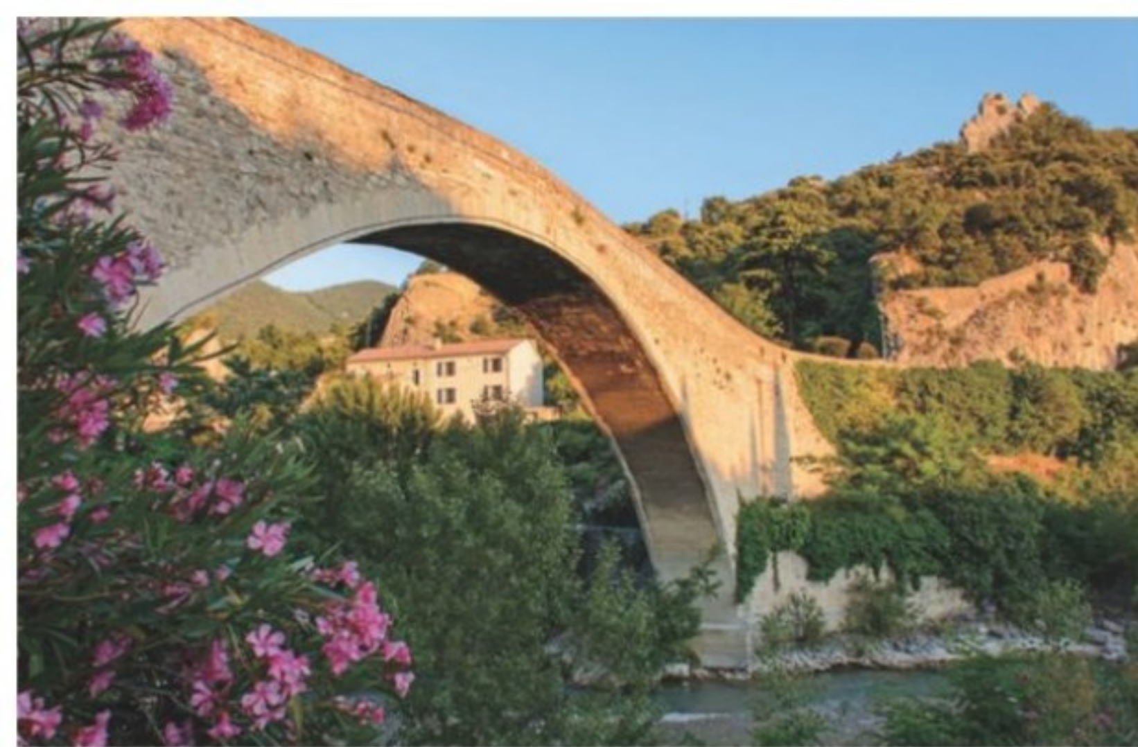
Oben: Die Pont de Nyons, eine 1409 fertiggestellte Steinbogenbrücke, besitzt die für die damalige Zeit außergewöhnliche Bogenspannweite von 40,53 Metern und war bis 1970 die einzige Brücke, auf der man in Nyons die Eygues überqueren konnte.
