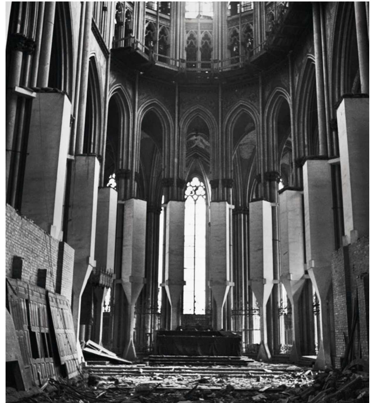
Chor mit Luftschutzverschalung der Chorfeilerfiguren
