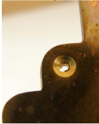
Abbildung 9.52: Einseitig erweitertes Zapfenlager
