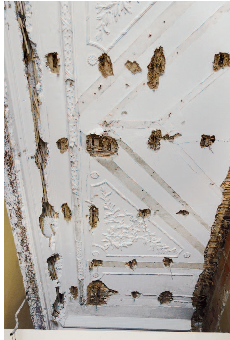
Umfangreiche Reste der bauzeitlichen Stuckdecke im Salon des ersten Obergeschosses (Balkonzimmer). Sie wurde in klassizistischer Gestaltung auf einem Lehm-/Strohputz eingebaut und teils frei angetragen, teils auch mit Modelstuck dekoriert. Sie enthält Reste einer aufwändigen Farbfassung mit Vergoldungen. Die Decke wurde bei der Renovierung unter Max Littmann noch einmal repariert und ergänzt, 1958 dann aber verdeckt. Zustand 2016 nach Rückbau zweier abgehängter Decken. Foto: Christian Schmidt 2016
