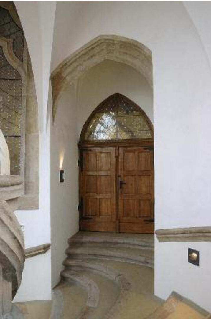
97 Meißen, Großer Wendelstein, Durchgang vom Treppenhaus zum Wohnbau mit doppelt gekrümmtem Bogen (AK)
