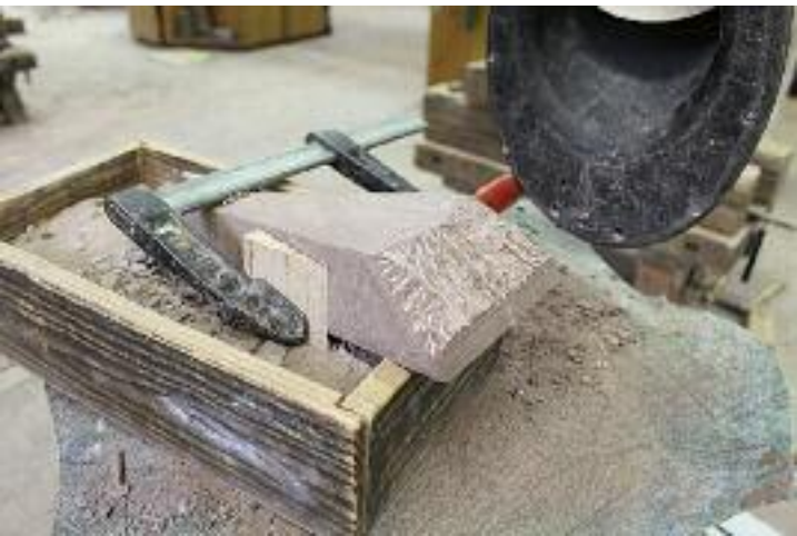
246 Abarbeiten der zylindrisch gekrümmten Bogenfront (MAA)
