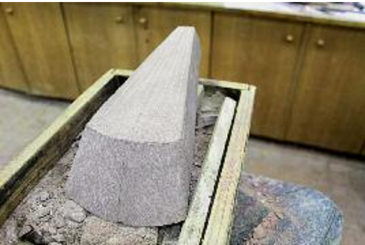
248 Fertiges Werkstück der Trompe mit gekrümmter Bogenfront (MAA)
