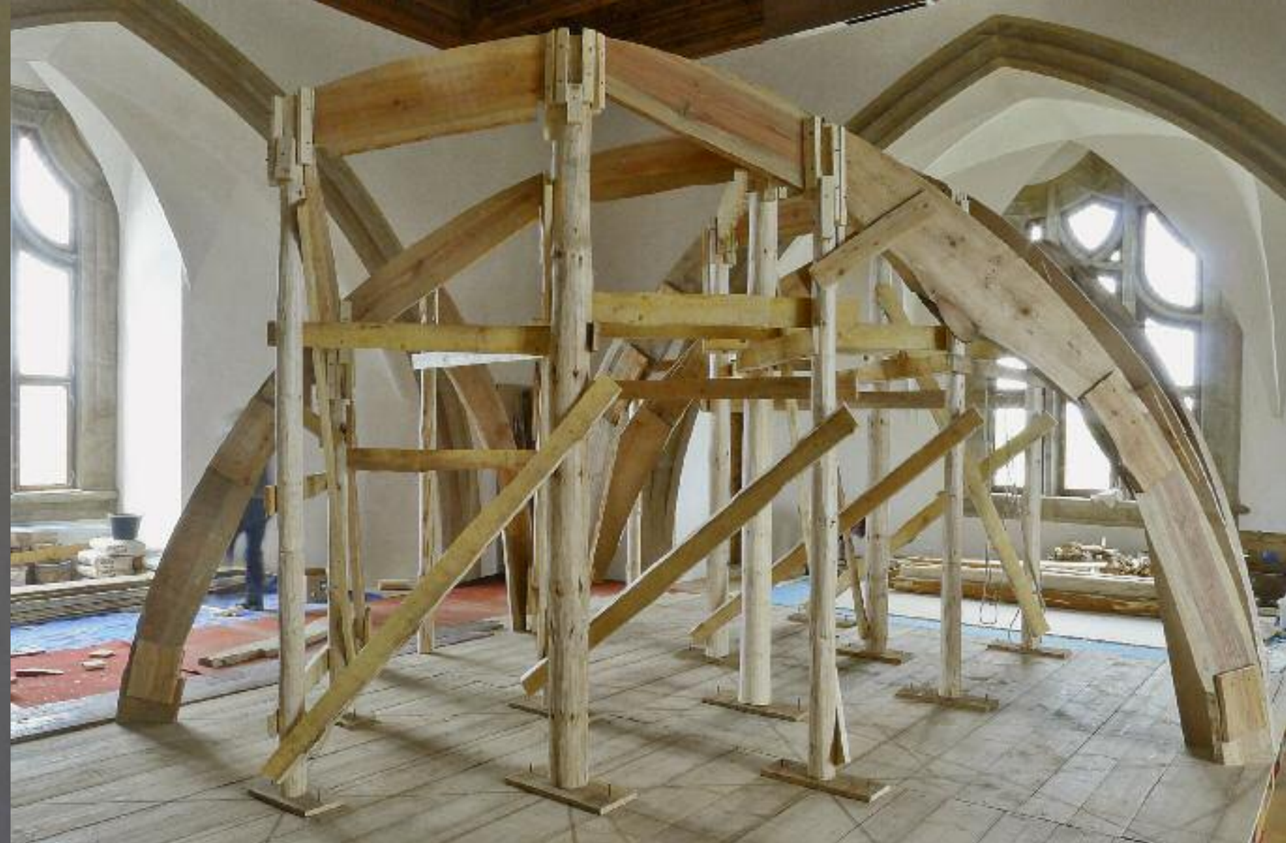
10 Experimenteller Nachbau von Arbeitsplattform, Reißboden und Lehrgerüst für ein spätgotisches Zellengewölbe in der Dauerausstellung der Albrechtsburg Meißen (DW)
