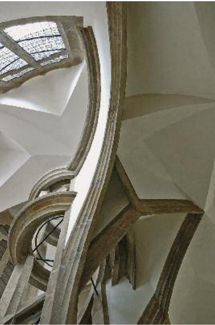
99 Meißen, Großer Wendelstein, Treppenabschluss mit doppelt gekrümmtem Bogen in Untersicht (AK)
