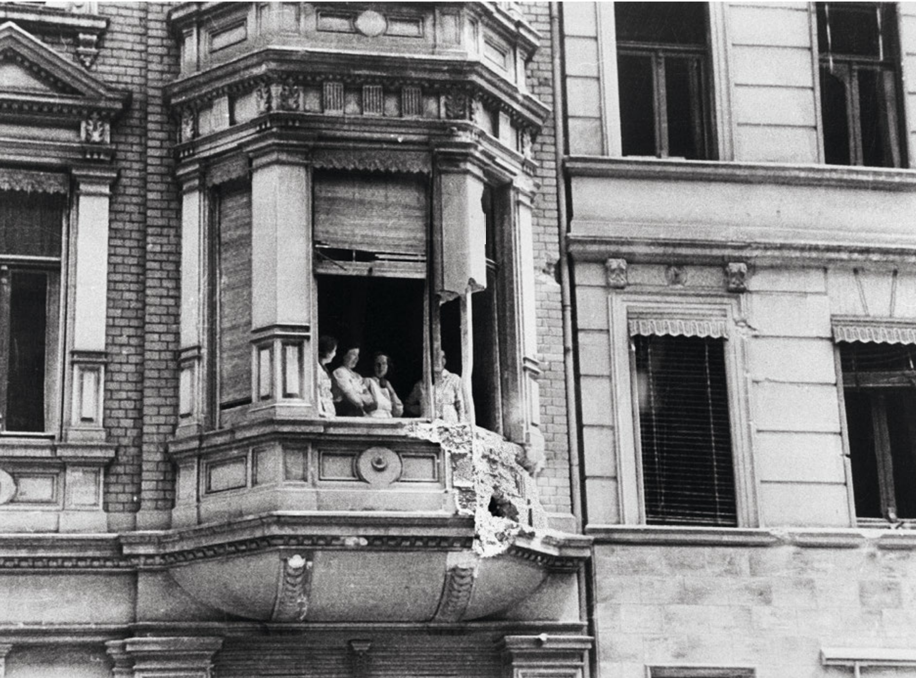
Bombentreffer Ungläubiges Staunen im Erker eines Gründerzeithauses, Foto: Erich Behnke, um 1940 oder kurz danach
