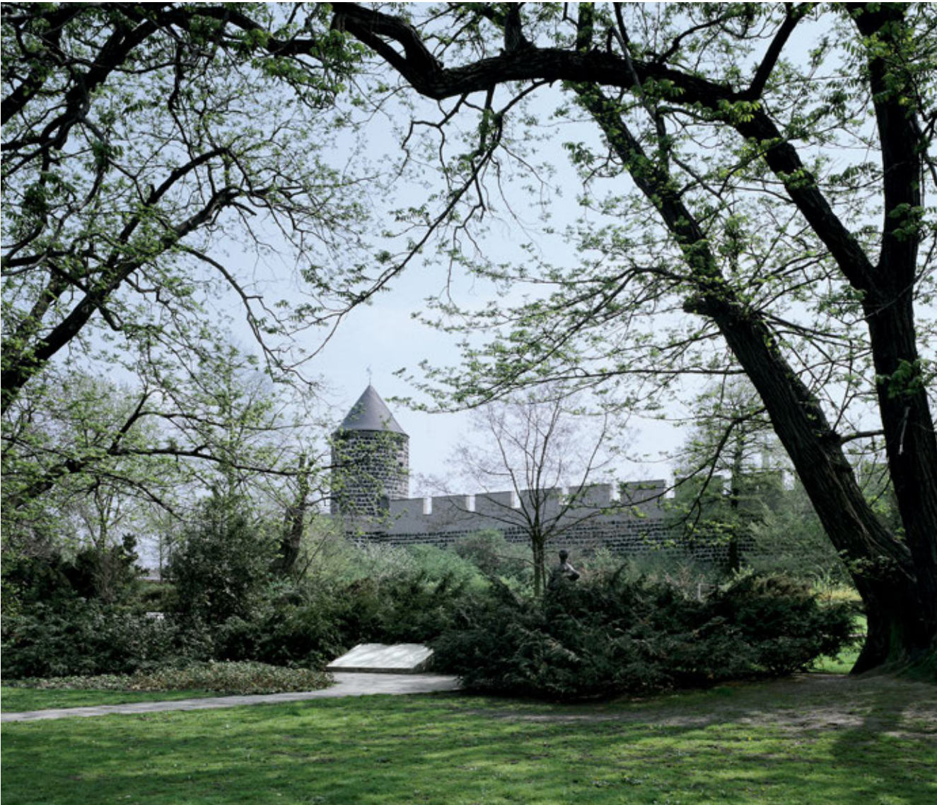
Der erhaltenen und wieder aufgebauten Stadtmauerpartie am Kartäuserwall ist ein Parkstreifen vorgelagert. Unten: Gereonsmühlenturm und mittelalterliche Stadtmauer am Hansaring.
