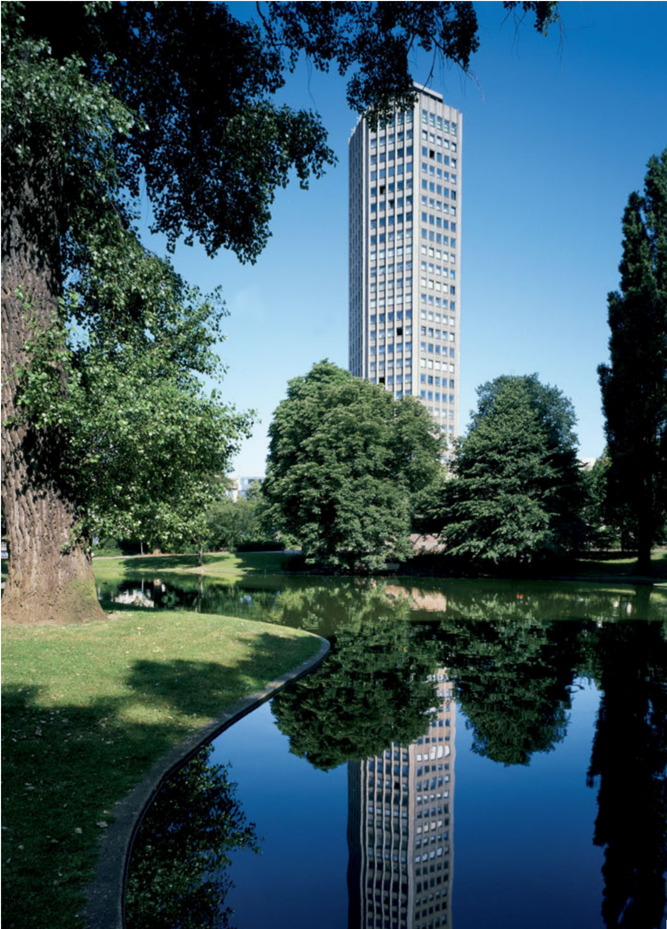
Das Wasser der Anlage am Theodor-Heuss-Ring spiegelt das sechseckige Ringturmhaus – womöglich als Tiefgarage? Übrigens erinnert dieser Wasserspiegel an den Sicherheitshafen des 19. Jahrhunderts, der etwa an dieser Stelle lag.
