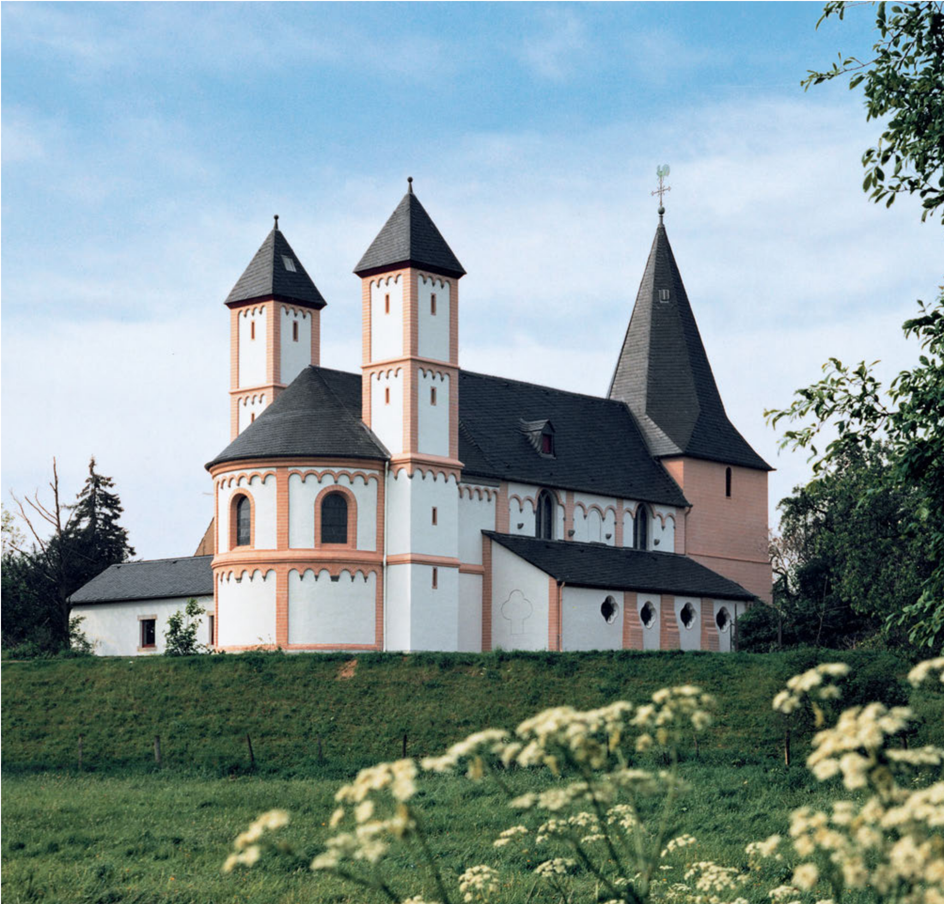
Schon weit stromabwärts zieht St. Amandus in Rheinkassel die Blicke auf sich. Der spät-romanischen Pfeilerbasilika hinter dem Rheindeich ist landeinwärts ein wuchtiger Westturm vorgesetzt, der ursprünglich ein Geschoss höher war.
