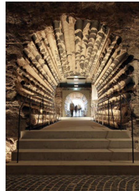
Abb. 2 Durchgang durch das Fundament des Südturms im neuen Eingangsgebäude an der Südseite des Doms
