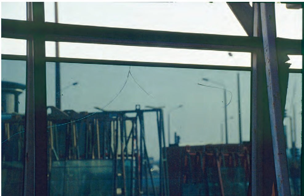
Thermischer Bruch an nicht vorgespanntem, absorbierendem Sonnenschutzglas.
