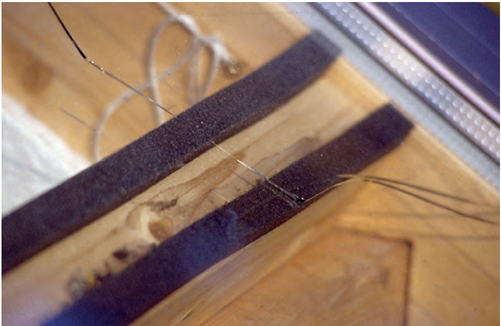
Thermischer Bruch an der unteren VSG-Scheibe von Isolierglas, die von der Warmzone (Raum) über die Auflage (schwarzes Profil = Erhitzung) in den Außenbereich (Kaltzone) läuft.
