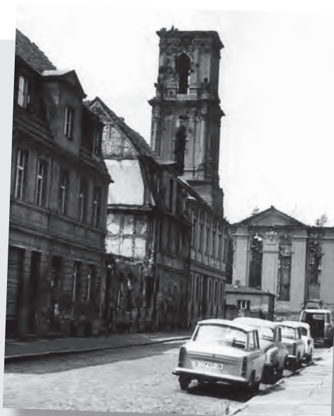
Trabant, Wartburg und Barkas vor der Ruine der Potsdamer Garnisonskirche.
