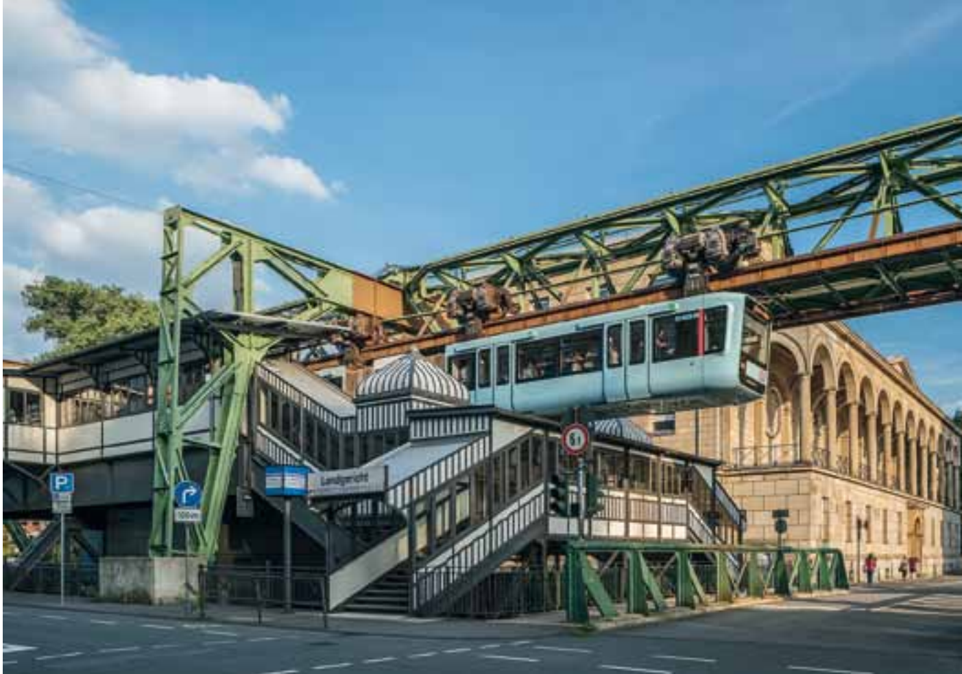
Schwebebahnstation Landgericht - Die Schwebbahnstation im Stadtteil Elberfeld südlich des Hardtberges wurde 1903 eröffnet und in den Jahren 2010/2011 originalgetreu im Jugendstil neugebaut. Architektonisch weist sie seitlich Kragdächer unterhalb der Tragkonstruktion zum Schutz der Bahnsteige auf. Die Gleise sind nicht überdacht. 1997 wurde sie in die Liste der Denkmäler der Stadt Wuppertal aufgenommen.
