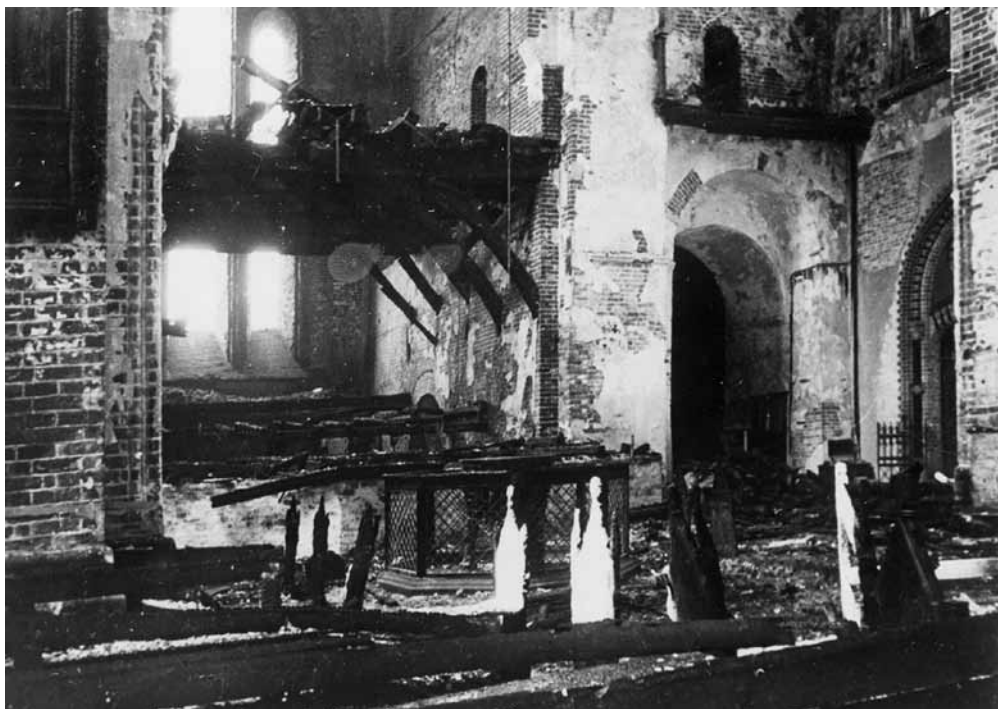
4 Das ausgebrannte Mittelschiff des Domes nach Nordwesten mit den verkohlten Resten des Laiengestühls. Aufgenommen am 1. April 1942.
