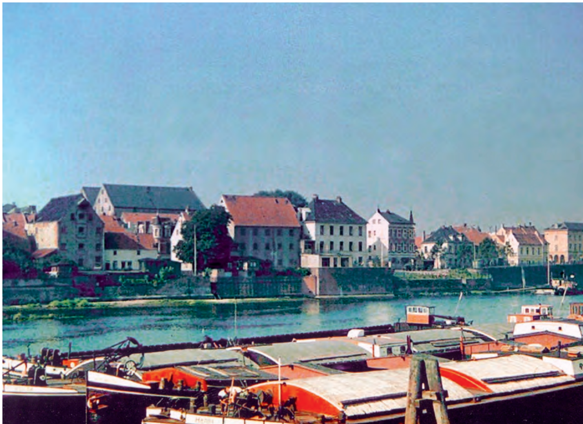
Die am gegenüberliegenden Ufer stehenden Häuser an der Herrlichkeit mit dem dahinter liegenden Flüsse–Straßen–Viertel. Ganz rechts der Bauhof (ehemaliges Arbeitshaus), Herrlichkeit 18, der 1830 bis 1831 nach Plänen von Friedrich Moritz Stamm errichtet worden war. Der Bauhof befand sich seit 1923 im Gebäude.
