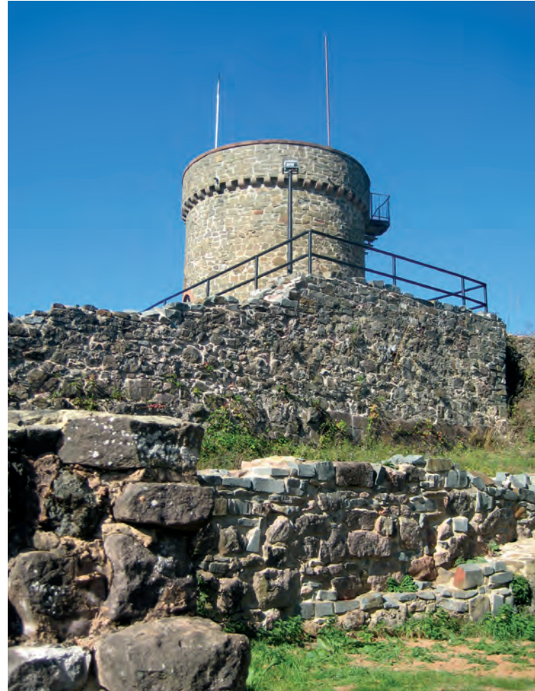
Mauerwerk am Burghang
