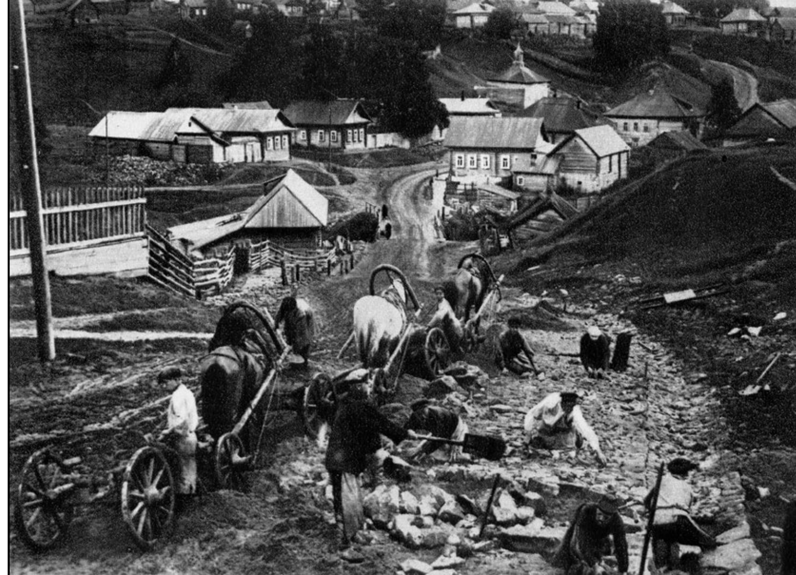
Das Dorf Smolentzewo. Durch eine Befestigung der Wege soll verhindert werden, dass diese im Frühjahr und Herbst wegen der Schlamperperiode nicht mehr passierbar sind. Fotograf unbekannt, vermutlich nach 1917.
