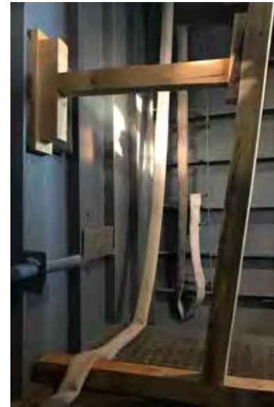
Herstellung eines Druckstempels zur Abdichtung eines Bodenschotts
