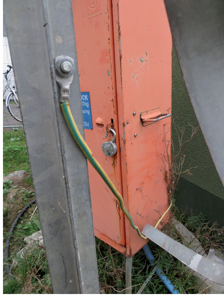
Bild 704.4 Anschluss einer Erdungsleitung an einen Staberder auf der Baustelle (Foto: Rolf Rüdiger Cichowski)
