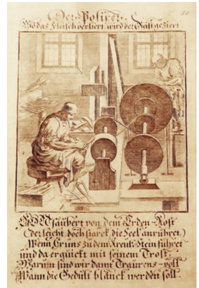
3 Stich: Der Polierer – in Wien ist dieses Handwerk als Metallschleifer für Buntmetalle bekannt: an der großen Scheibe wird grob geschliffen, an der kleinen, breiten Tuchscheibe, anschließend mit Rouge poliert
