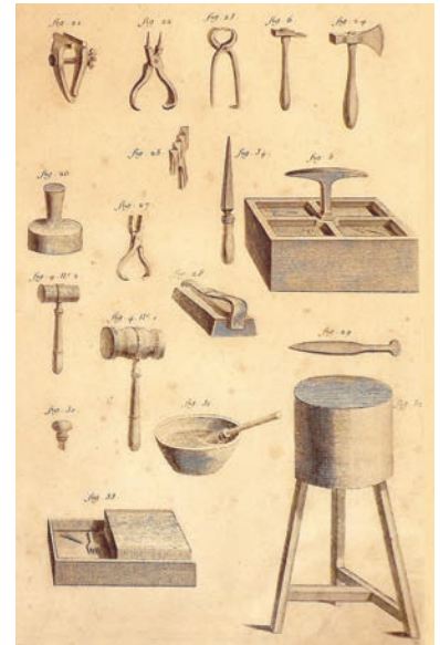
2 Der Stich zeigt die Werkzeuge für Messingbearbeitung eines Gürtlers, ca. 1740, Zangen, Hämmer, Feilen
