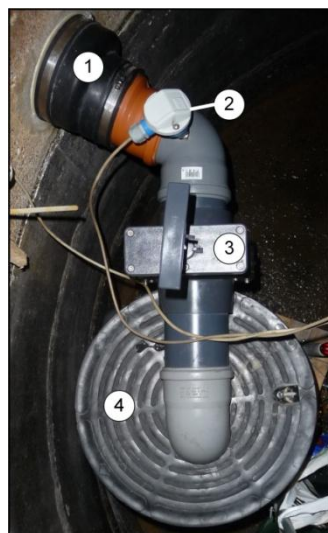
Abb. 5-4: Anschluss der Probenahmetechnik (links) und Rückführung des Grauwassers in die nachfolgende Zweikammerabsetzgrube (rechts) in Lübeck Flintenbreite
