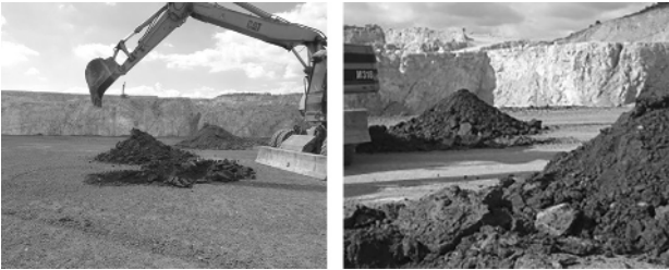
Bild 14. Beprobung des bereits eingebauten Tunnelausbruchs
