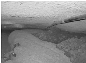
Bild 11 Einbau von pyrithaltigem Material im Zugangstunnel Umpfental
