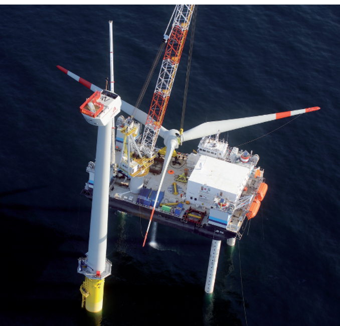
Montage einer Windenergieanlage im Offshore-Windenergiepark Alpha Ventus, der 2009 in der Nordsee in Betrieb ging (Foto: alpha ventus).
