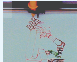
CAD mit Stiftplotter, Kurven werden mit Polygonen angenähert, 1978
