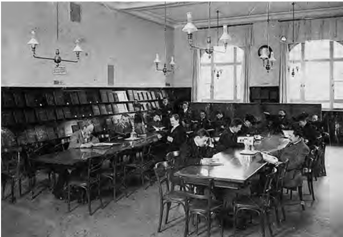
Die alten Lesesäle vor dem Umbau.
